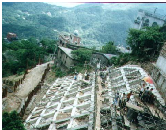
圖 4-1 風災後的重建工程
