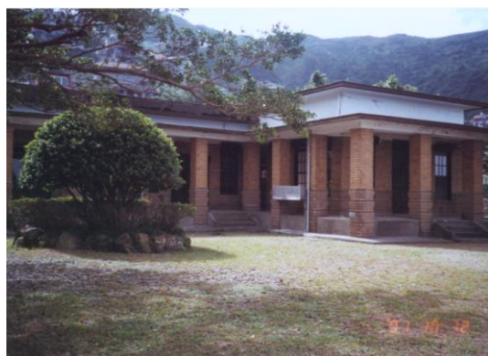
圖 2-17 台陽礦業事務所外觀〈側面〉
