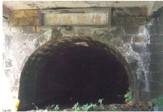
圖 1-3 建基礦業自行鑿穿的臨海隧道，為運礦之用
