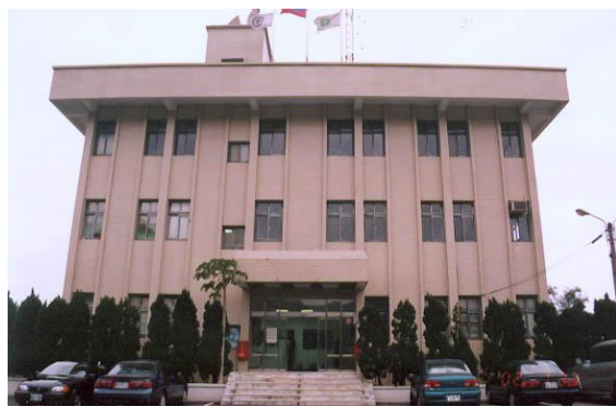
圖 3-12 中國石油深澳港供輸服務中心
