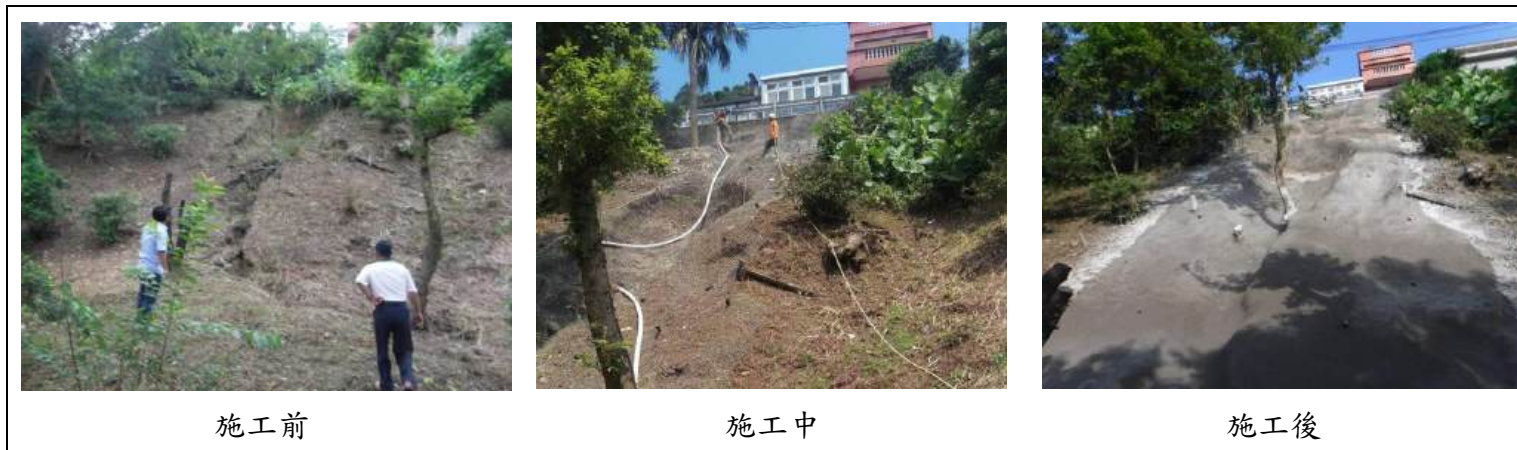
圖 6-6 頌德里金山寺旁道路邊坡施工情形
