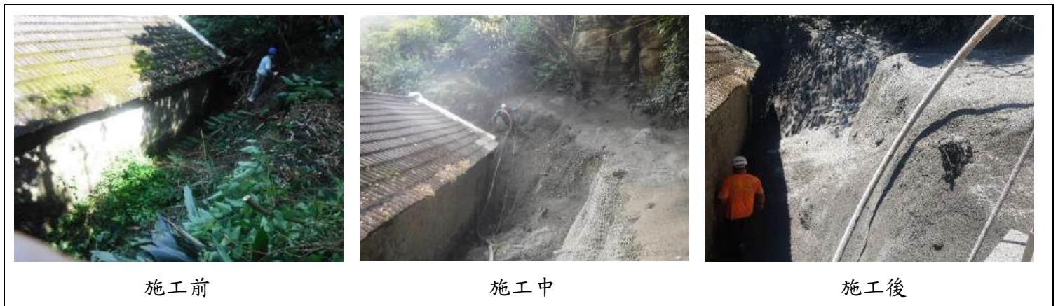
圖 6-18 鼻頭路 55 號後方邊坡掛網噴漿護坡施工情形
