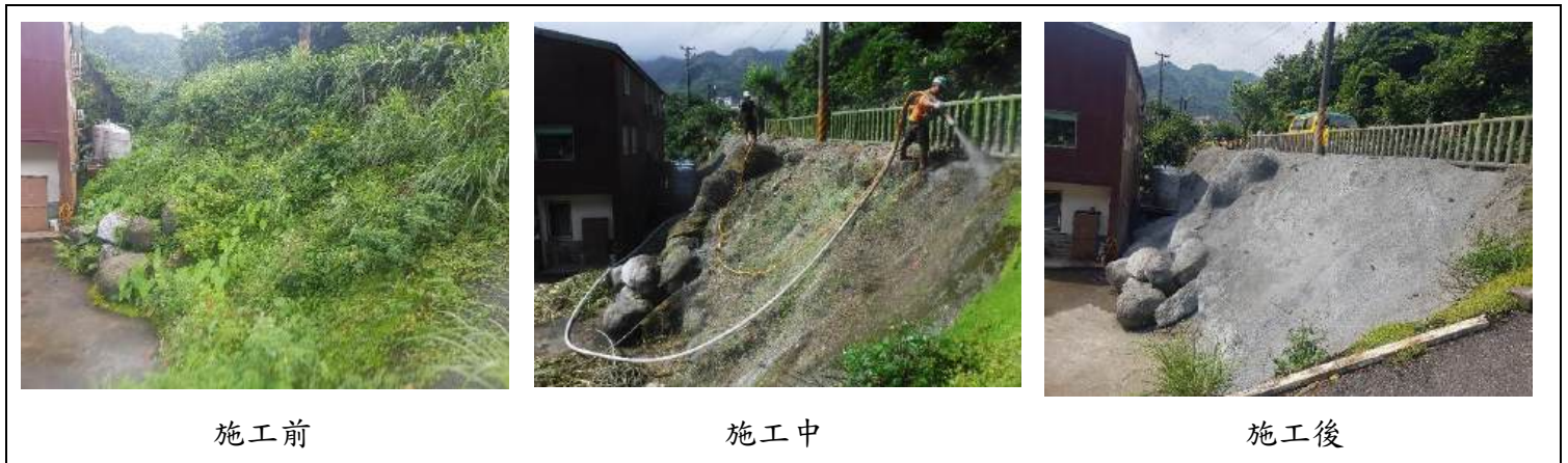
圖 6-17 山尖路 86 號邊坡掛網噴漿施工情形
