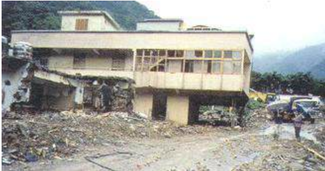
圖 6-4 象神颱風對民宅造成之損害
