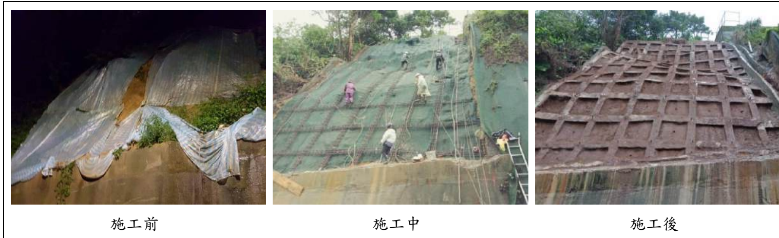
圖 6-16 阿美家園邊坡改善施工情形
