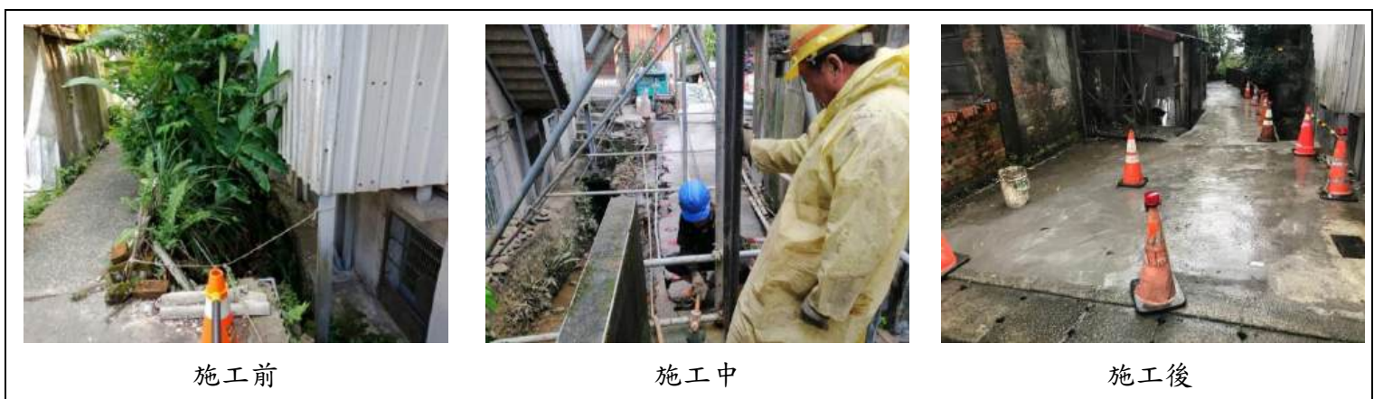
圖 6-20 中央路 25 號前排水溝牆修繕施工情形
