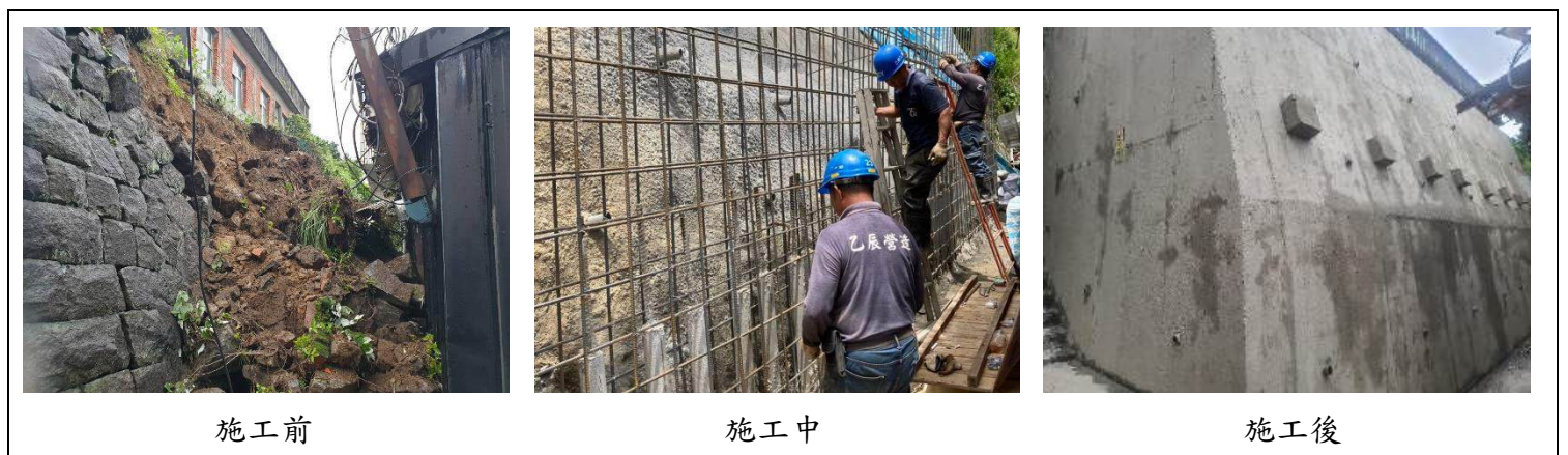
圖 6-21 濂洞里洞頂路 47 號旁擋土牆整修施工情形
