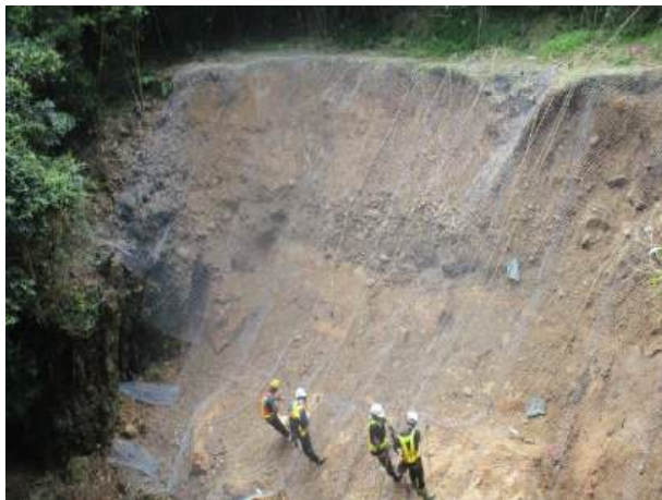
地點：粗坑口一巷籃球場旁野溪
