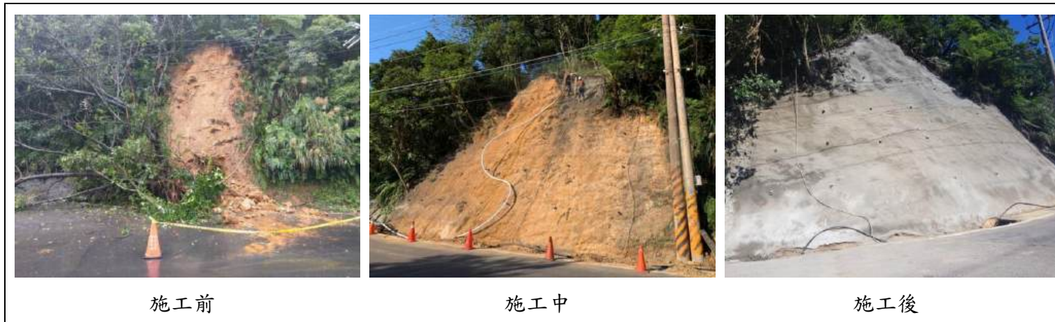
圖 6-14 四腳亭埔路 20 號崩塌施工情形
