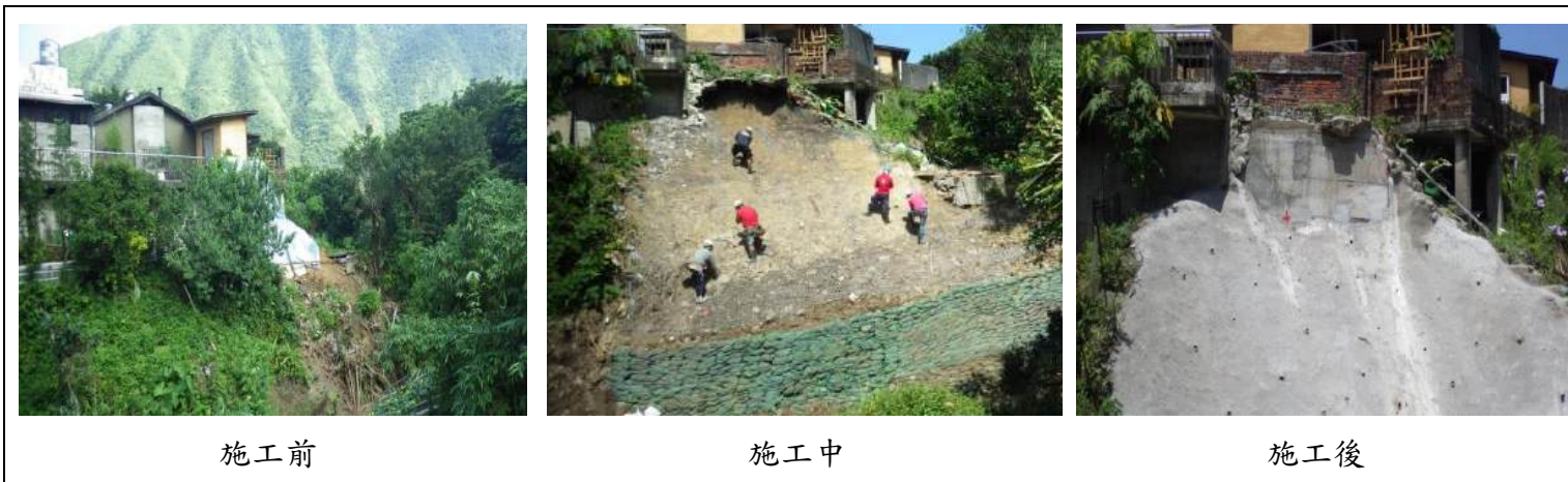
圖 6-12 五號道路 117 號邊坡崩塌施工情形
