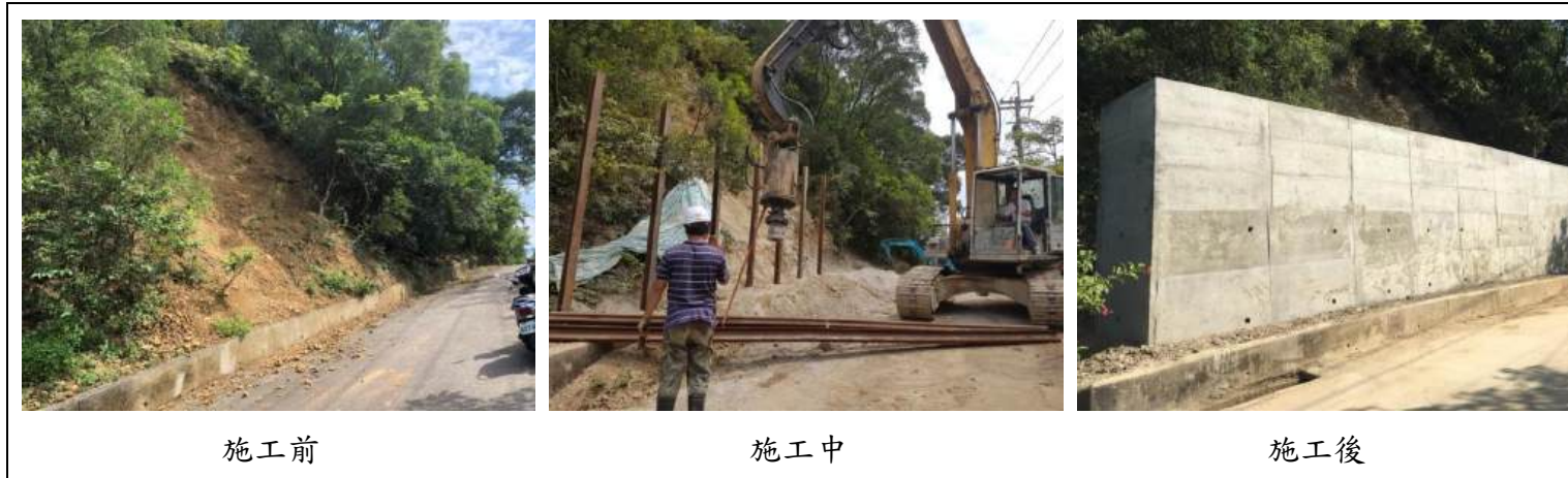
圖 6-13 瑞芳公園崩塌改善施工情形
